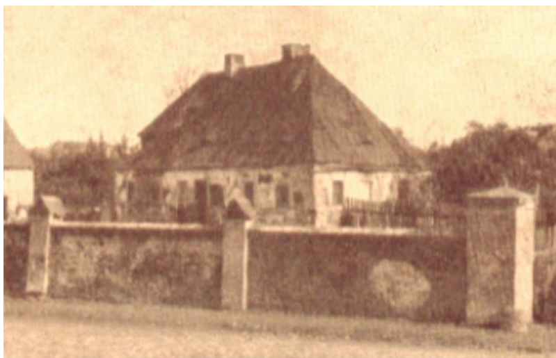
Manor house at number 5 on Garten Strasse in Polnischdorf – Trebnitz.
